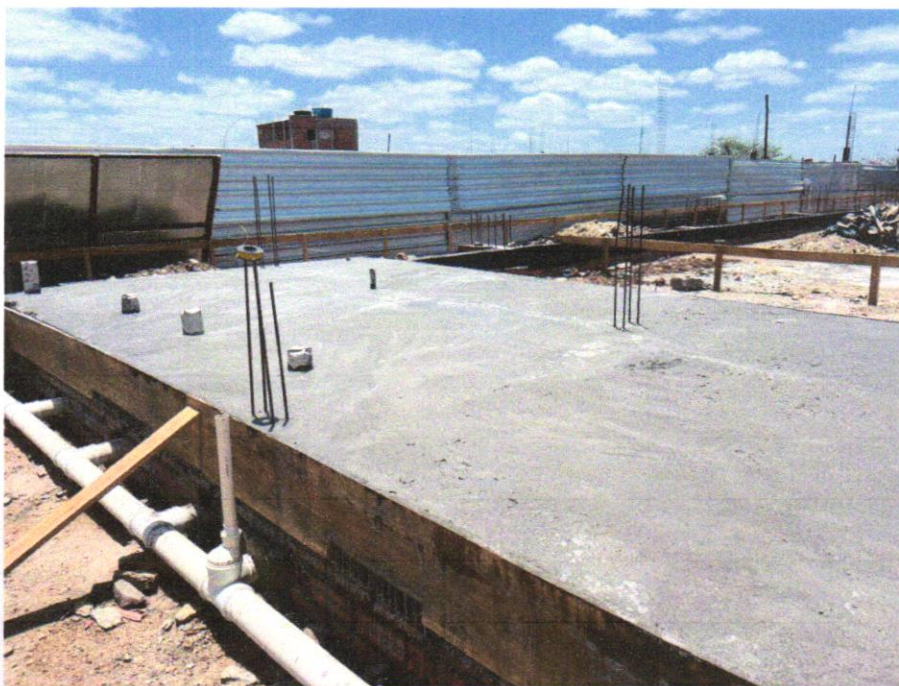
IMAGEM 09 - CONCRETAGEM DE PILARES, FCK = 25 MPA, COM USO DE BOMBA EM EDIFICAÇÃO COM SEÇÃO MÉDIA DE PILARES MENOR OU IGUAL A 0,25 M 2 - LANÇAMENTO, ADENSAMENTO E ACABAMENTO. AF_12/2015
