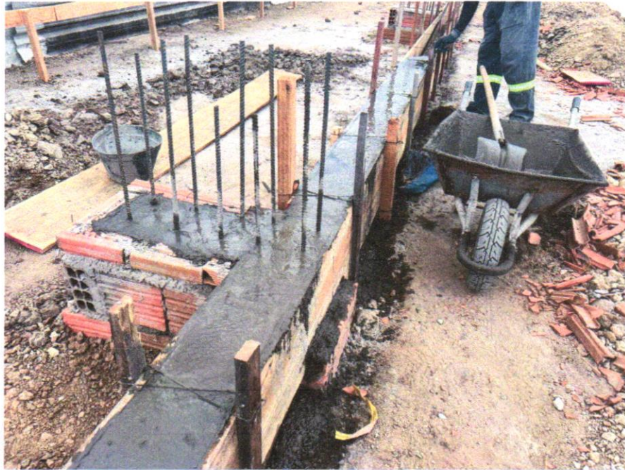
IMAGEM 03 - CONCRETAGEM DE PILARES, FCK = 25 MPA, COM USO DE BOMBA EM EDIFICAÇÃO COM SEÇÃO MÉDIA DE PILARES MENOR OU IGUAL A 0,25 M 2 - LANÇAMENTO, ADENSAMENTO E ACABAMENTO. AF_12/2015
