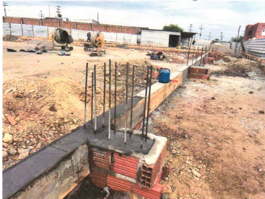
IMAGEM 04 - CONCRETAGEM DE PILARES, FCK = 25 MPA, COM USO DE BOMBA EM EDIFICAÇÃO COM SEÇÃO MÉDIA DE PILARES MENOR OU IGUAL A 0,25 M 2 - LANÇAMENTO, ADENSAMENTO E ACABAMENTO. AF_12/2015
