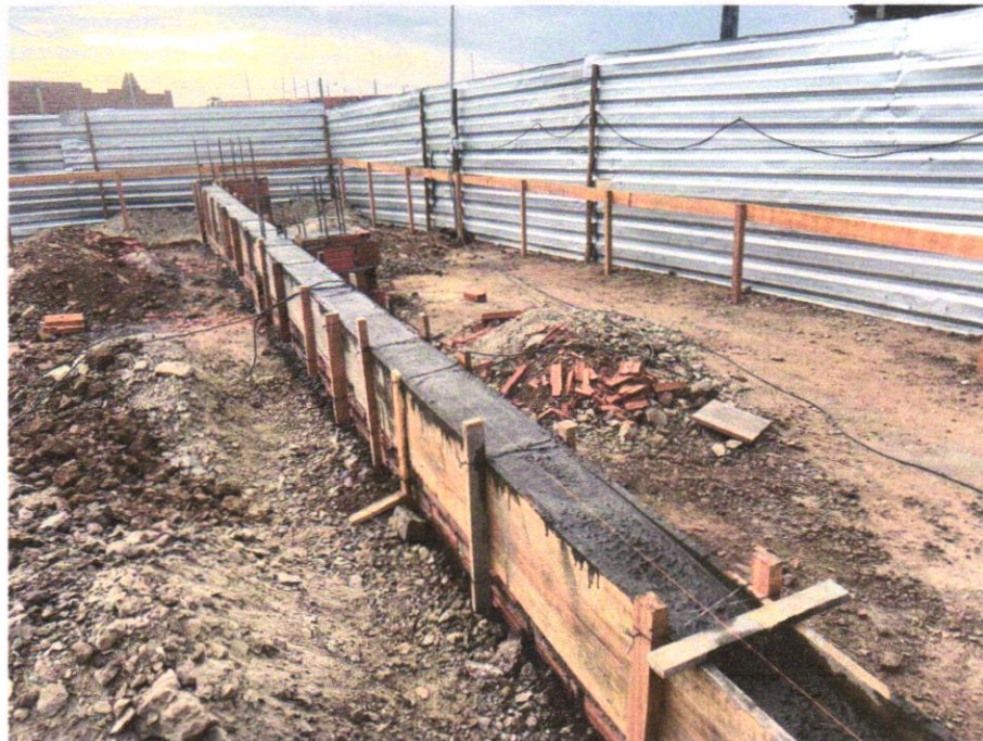
IMAGEM 02 – FABRICAÇÃO, MONTAGEM E DESMONTAGEM DE FÔRMA PARA VIGA BALDRAME, EM CHAPA DE MADEIRA COMPENSADA RESINADA, E=17 MM, 4 UTILIZAÇÕES. AF_06/2017
