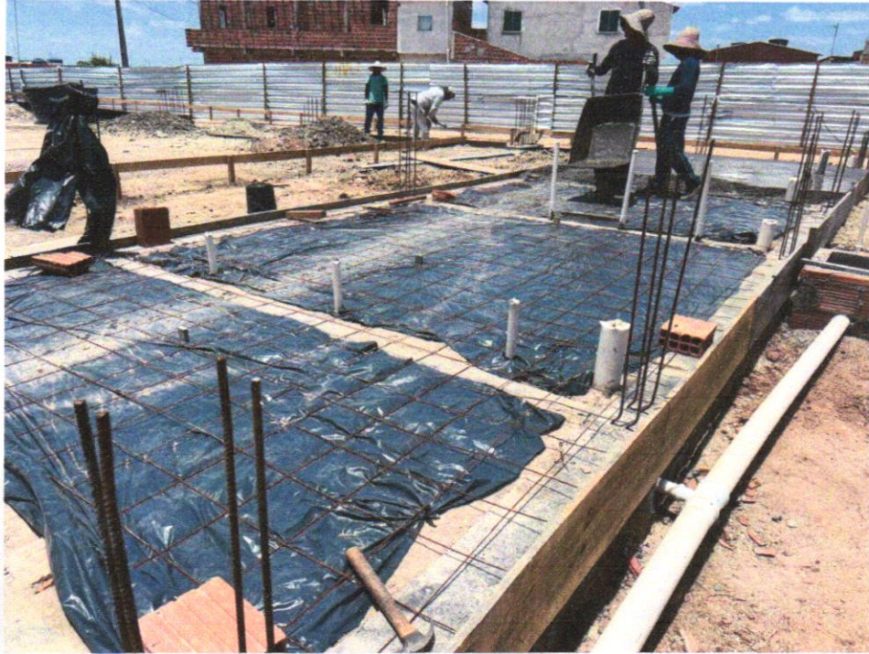
IMAGEM 07 ARMAÇÃO PARA EXECUÇÃO DE RADIER, PISO DE CONCRETO OU LAJE SOBRE SOLO, COM USO DE TELA Q-92. AF_09/2021
