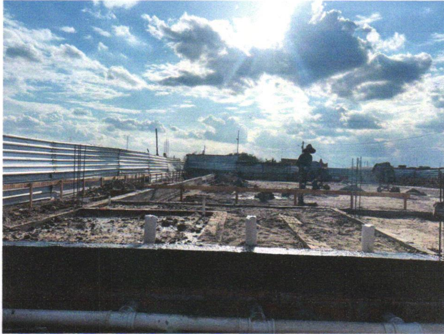
IMAGEM 13 – IMPERMEABILIZAÇÃO DE SUPERFÍCIE COM EMULSÃO ASFÁLTICA, 2 DEMÃOS AF_06/2018
