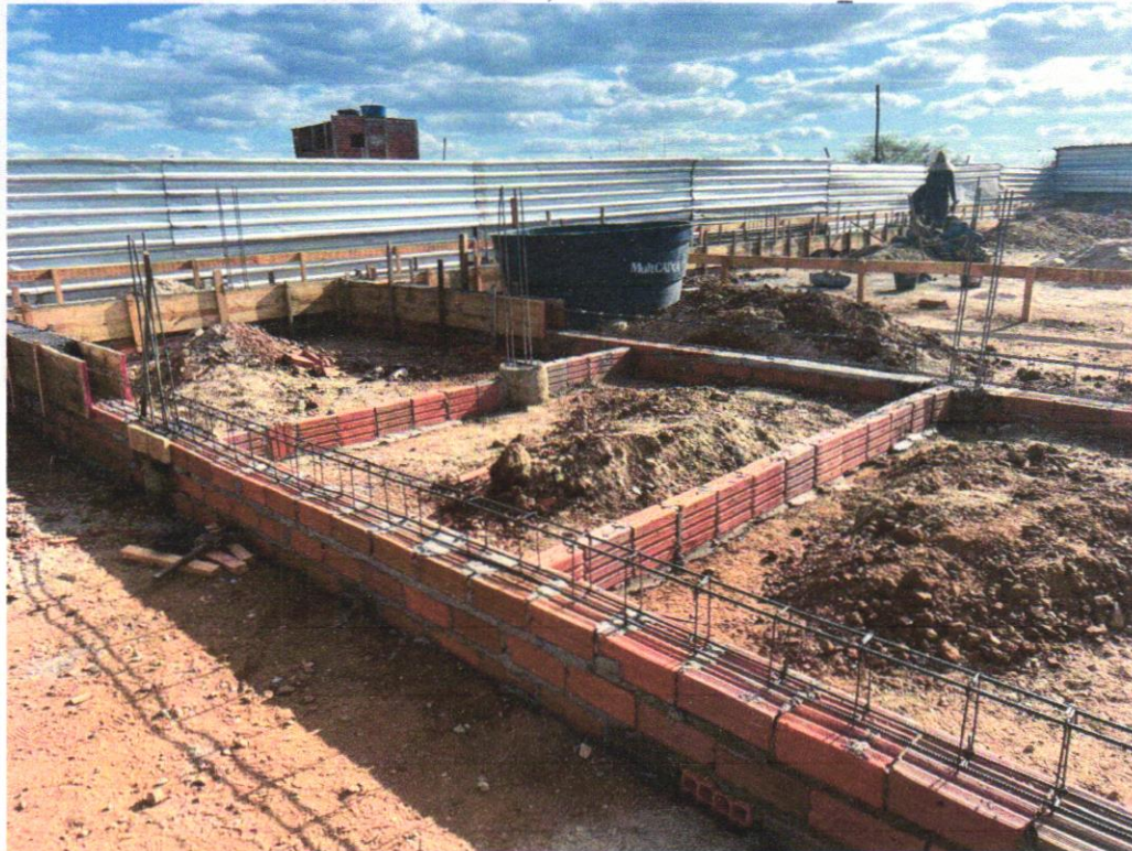
IMAGEM 06 - CORTE E DOBRA DE AÇO CA-50, DIÂMETRO DE 8,0 MM, UTILIZADO EM ESTRUTURAS DIVERSAS, EXCETO LAJES. AF_12/2015
